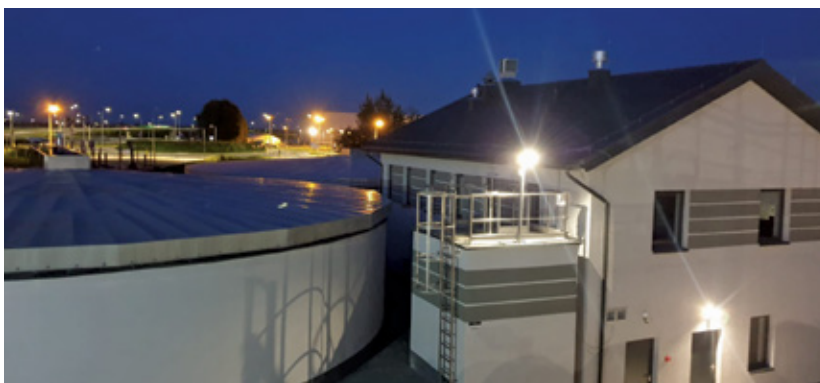
Fot. 2. Oczyszczalnia ścieków „Zamienie” po rozbudowie
