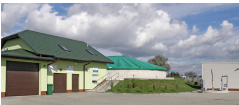
Fot. 3. Oczyszczalnia ścieków „Zamienie” przed rozbudową
