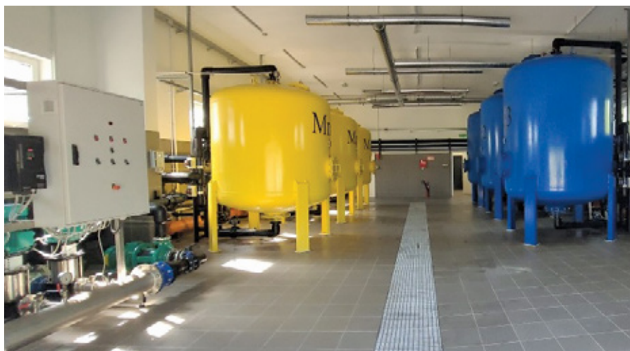
Fot. 8. Stacja uzdatniania wody „Zamienie”
