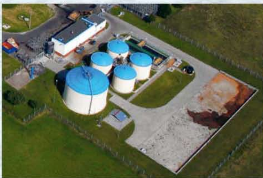
Oczyszczalnia ścieków dla przemysłu owocowo-warzywnego w Dąbrowie Chełmińskiej, woj. kujawsko-pomorskie.
