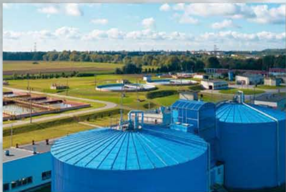
Widok części mechanicznej, oczyszczalni ścieków Fordon w Bydgoszczy.
